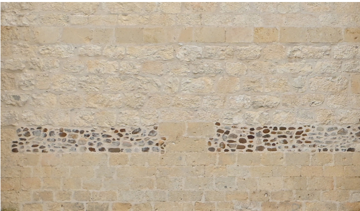
Materialidad de los muros de la iglesia
