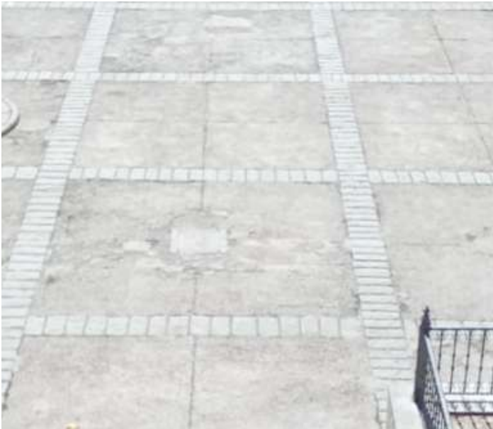
Encintado granito existente
